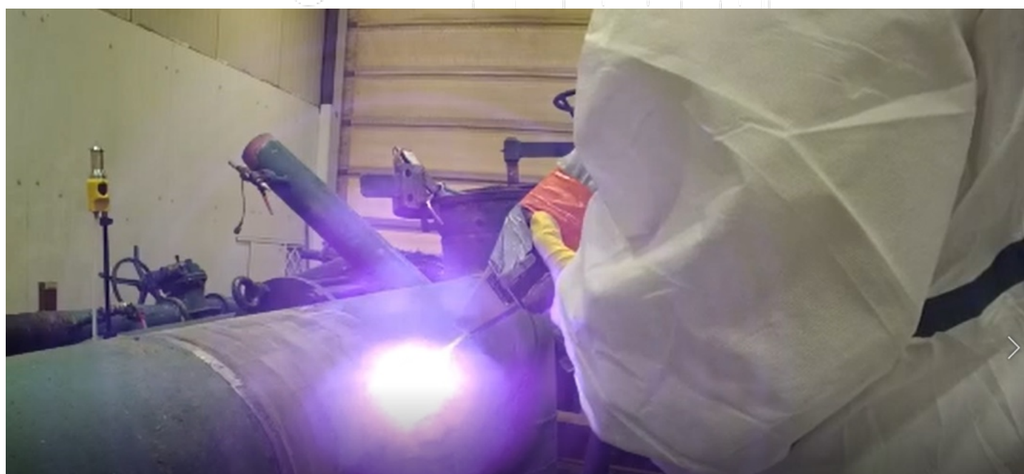
Décapage manuel en salle blanche - Résultat mesure sur opérateur: concentration < 4,29f/l.
