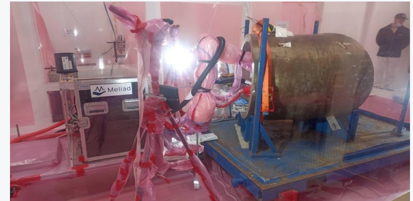
Décontamination nucléaire Décapage avant/après soudage Intervention en zone hostile / Retrait de peintures plomb, amiante et CMR
