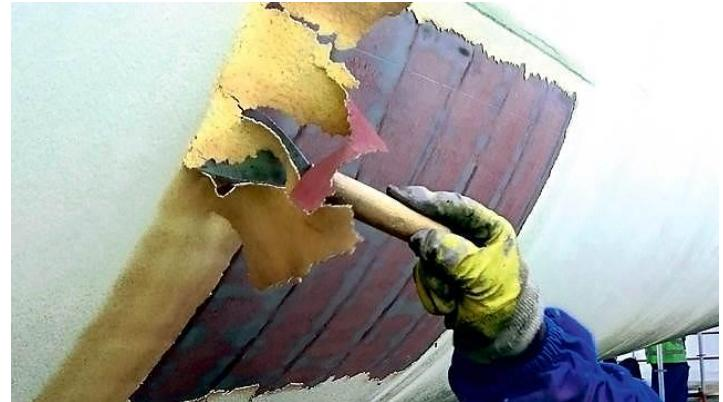
Le décapage de revêtements par induction utilise l'induction électromagnétique pour éliminer de manière efficace les revêtements appliqués sur les surfaces métalliques. En générant une chaleur localisée, cette méthode provoque la séparation thermique du revêtement par rapport au substrat, ce qui permet un retrait rapide et propre, sans avoir recours à des abrasifs ni à des produits chimiques.
